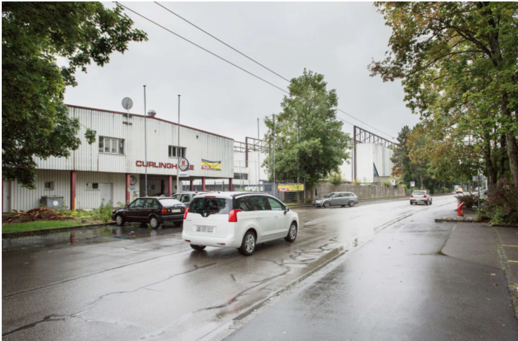
Die Eisfeldstrasse ist immer noch normal befahrbar, obwohl hier die Werksleitungsarbeiten seit letztem Monat laufen sollten.
